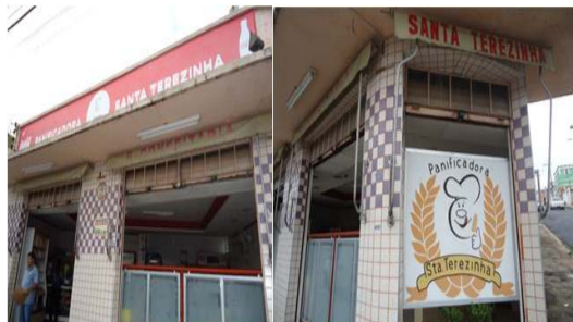
Panificadora Santa Terezinha situada à Rua Dom Pedro II nº 136 - Centro
